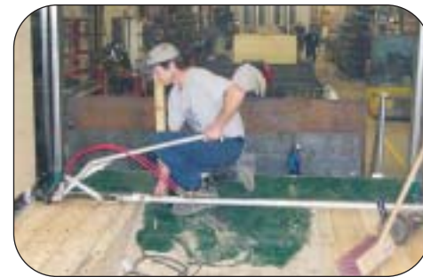
Le perçage des trous est facilité par l'utilisation d'une barre horizontale avec levier. On reconnaît ici Serge Ouellet qui actionne le levier de la perceuse.
