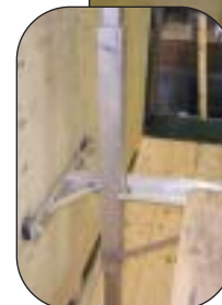
On aperçoit les deux supports ajustables servant à effectuer les découpes des planches. En mortaise : Détail d'un support ajustable.
